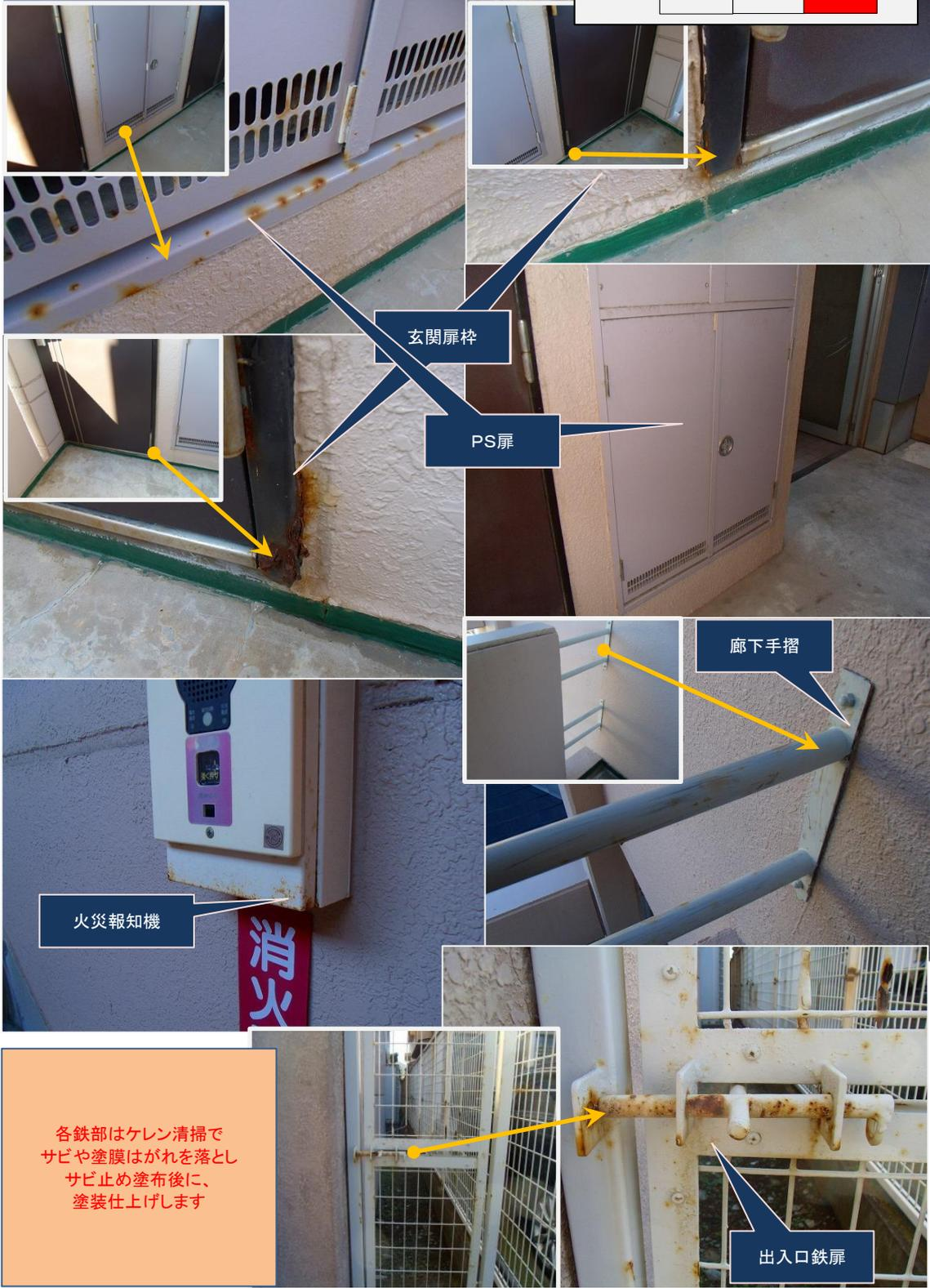
各鉄部はケレン清掃でサビや塗膜はがれを落としサビ止め塗布後に、塗装仕上げします
